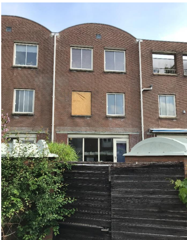
Foto 2: foto achterzijde Pastoor Jansenstraat 11
